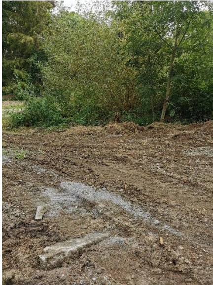
Abbildung 19: Teilweise befinden sich Fundamentreste bzw. Betonbruchstücke im Boden
